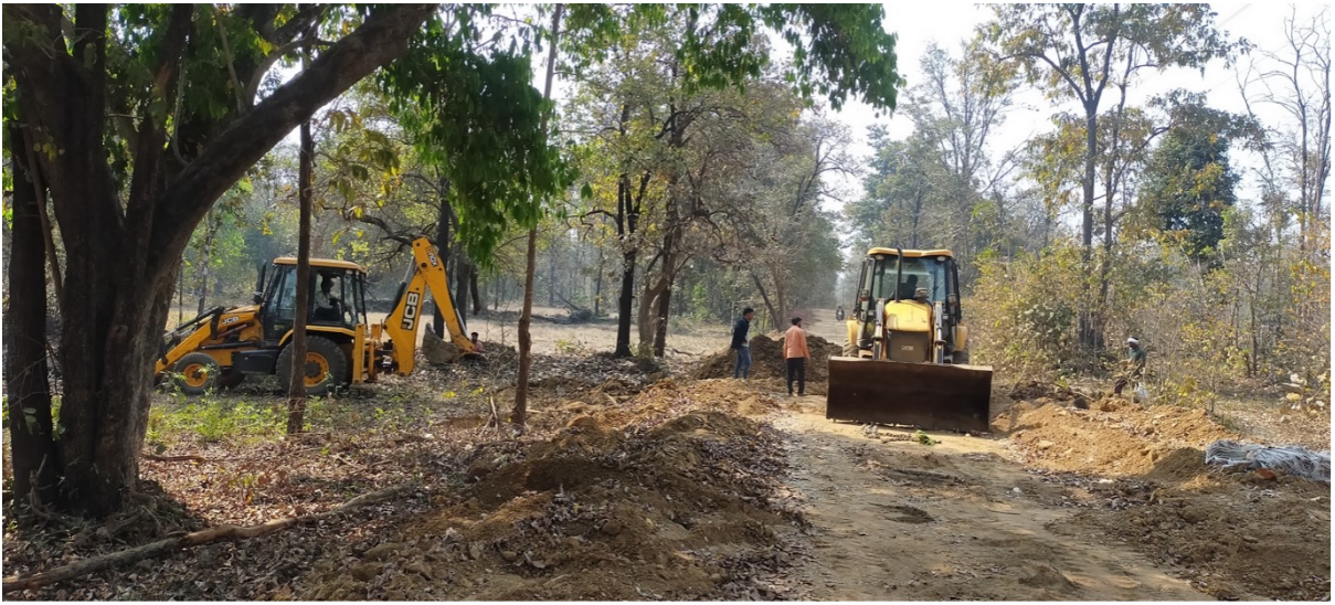
चित्र 22: चिलपरास के निकट सड़क निर्माण
